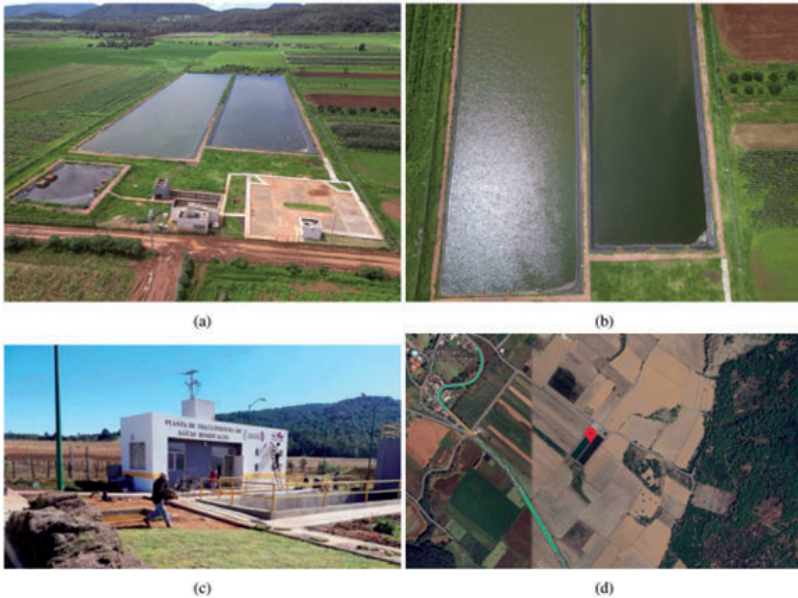
Figura 10. (a) PTAR ubicada en San Francisco Pichátaro. (b) Vista de las lagunas. (c) Entrada a la PTAR. (d) Vista aérea. Imagen tomada de (Orozco y col., 2025).
