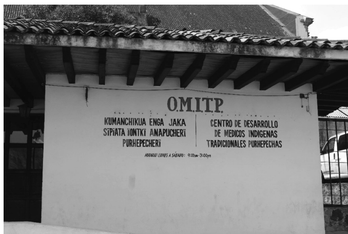
Figura 9. Fachada del edificio que alberga las instalaciones del OMITP.
